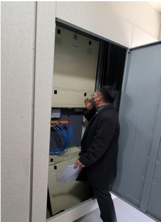
그림 2-7 | TPS실 설치 공간 미확보 사례 2
