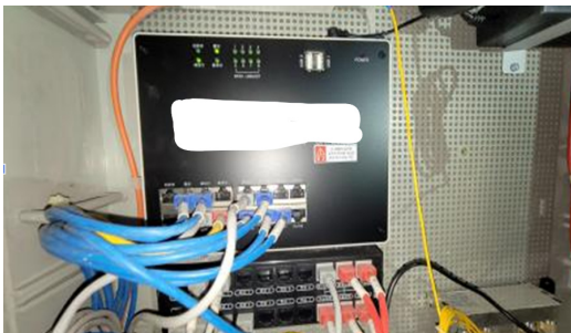
그림 3-5 | 홈게이트웨이 설치
