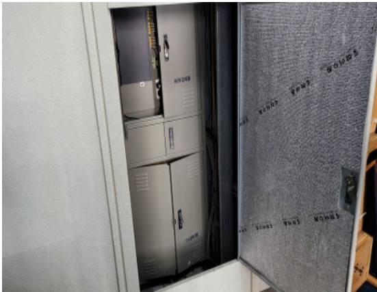
그림 2-5 | TPS실 설치 공간 미확보 사례 1
