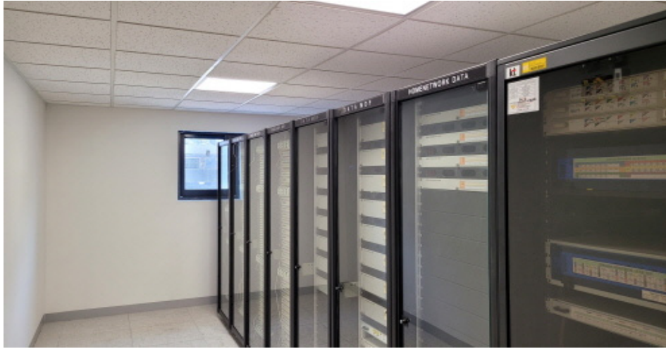
그림 2-2 | 방재실의 홈네트워크 설비의 설치 랙
